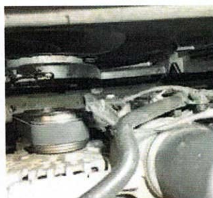
1.2 - Läckage/olja/vatten Kylarvätska var under min. Oljeläckage framsidan av motorn. OBS olja på/omkring rem.
